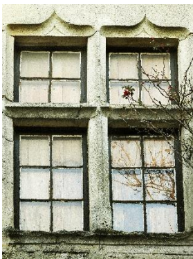
Fenêtre à meneaux
