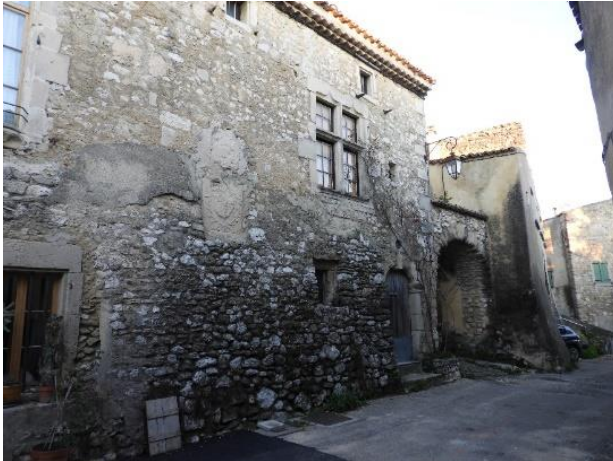
La maison « Sous l'Arc »
